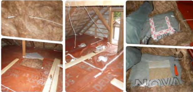
Padlásfödém hőszigetelés monitoringrendszere
